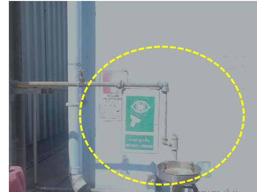
รูปที่ 2-29 ผักบัวอาบน้ำ ล้างตาฉุกเฉิน
